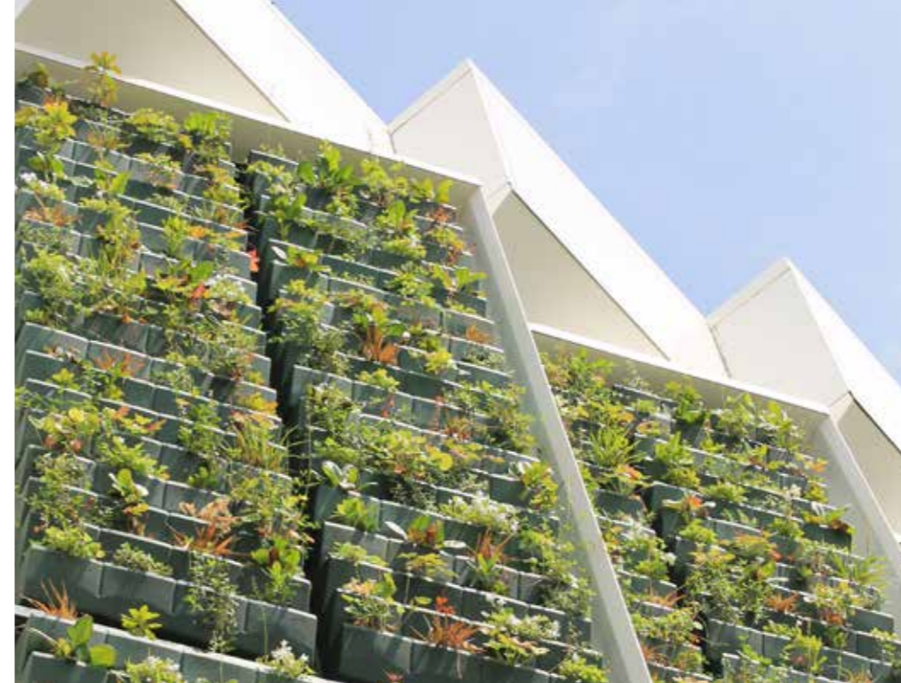
De groene wand, met vleermuiskasten, van het a.s.r.-gebouw
